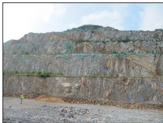
照片2-11 露天采场台阶覆土绿化
