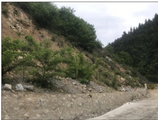
照片2-10 滑坡治理修挡墙及覆土绿化
