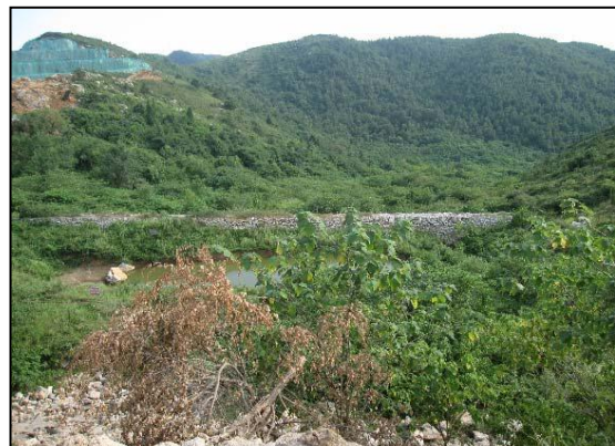
照片 2-13 排土场下方修拦渣坝
