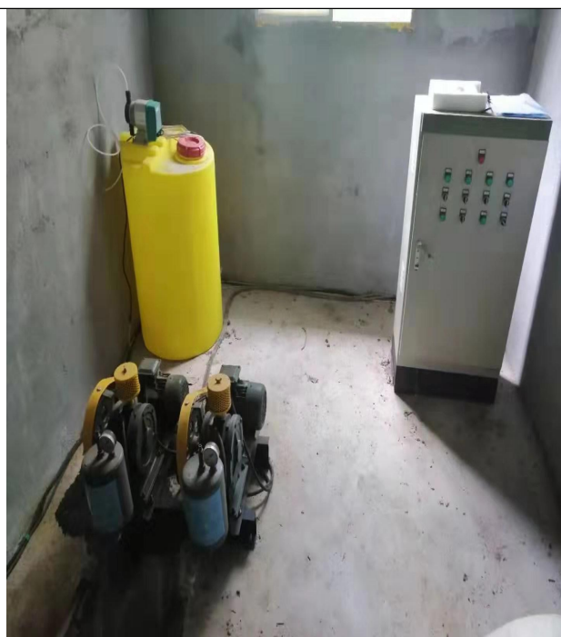
厂房隔音措施
