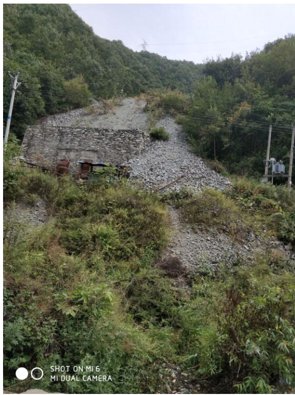
PD3 下废石溜槽旁散落的废石
