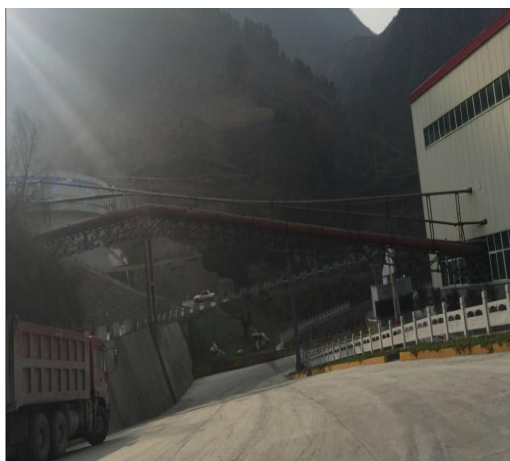
尾矿运输管道
